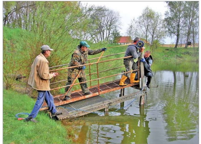
Einbau der Pumpe an der Lehmgrube Lommatzsch
