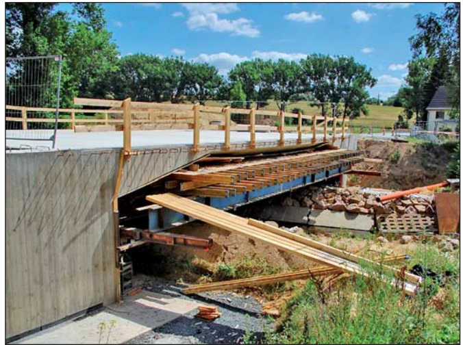
Mertitzer Brücke nimmt Gestalt an
