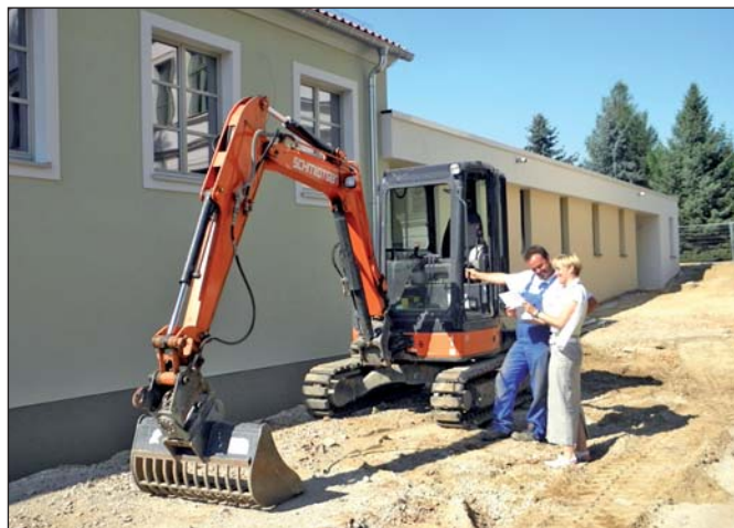
Die letzten Baumaßnahmen im Außenbereich der sanierten Sporthalle der Lommatzscher Grundschule sind im vollen Gange. Mit Schuljahresbeginn soll Eröffnung sein. Foto: KK
